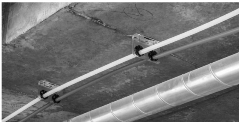
Figura 24: Apoyar a tubería PEX en rollos de menor diámetro
